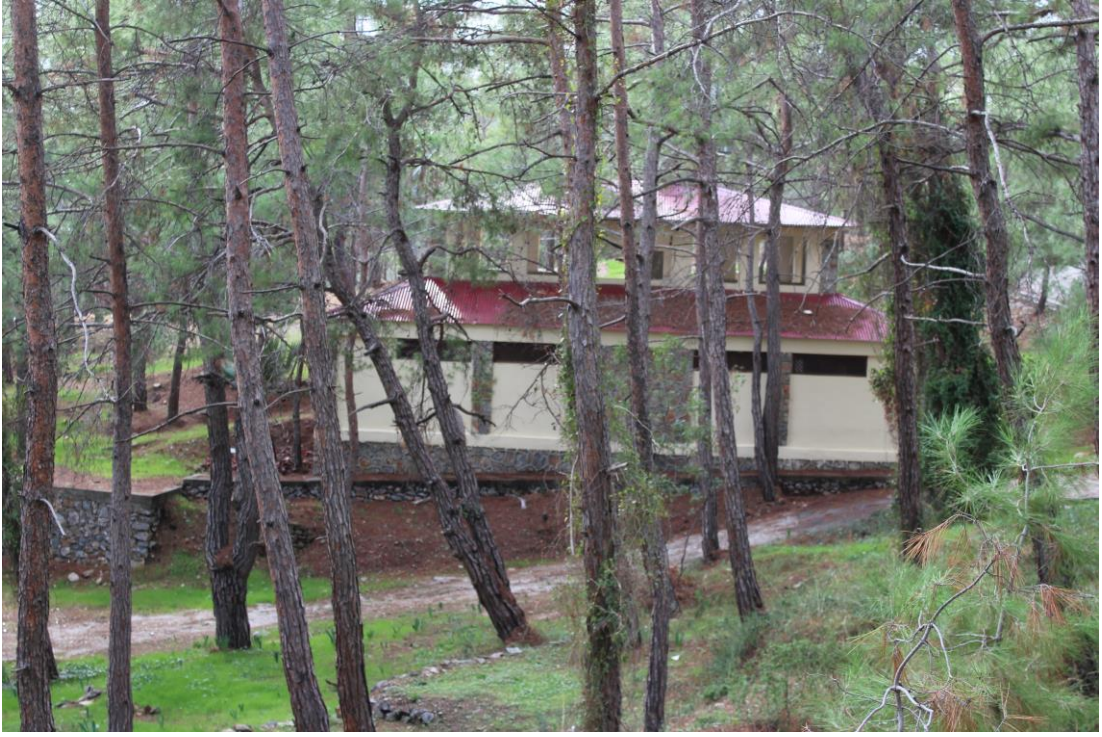
Resim 9. Kamp Alanı Ortak Kullanım Binası
