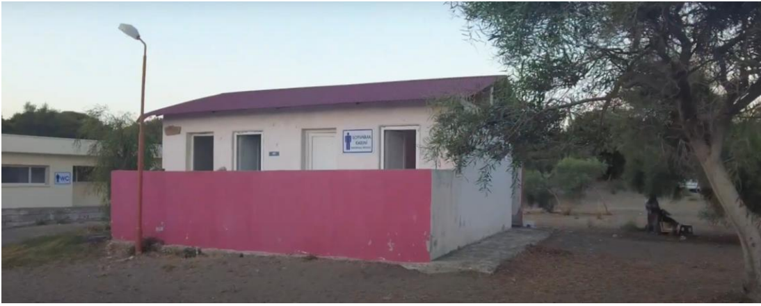
Resim 12. Sıhhi Tesis Binası
