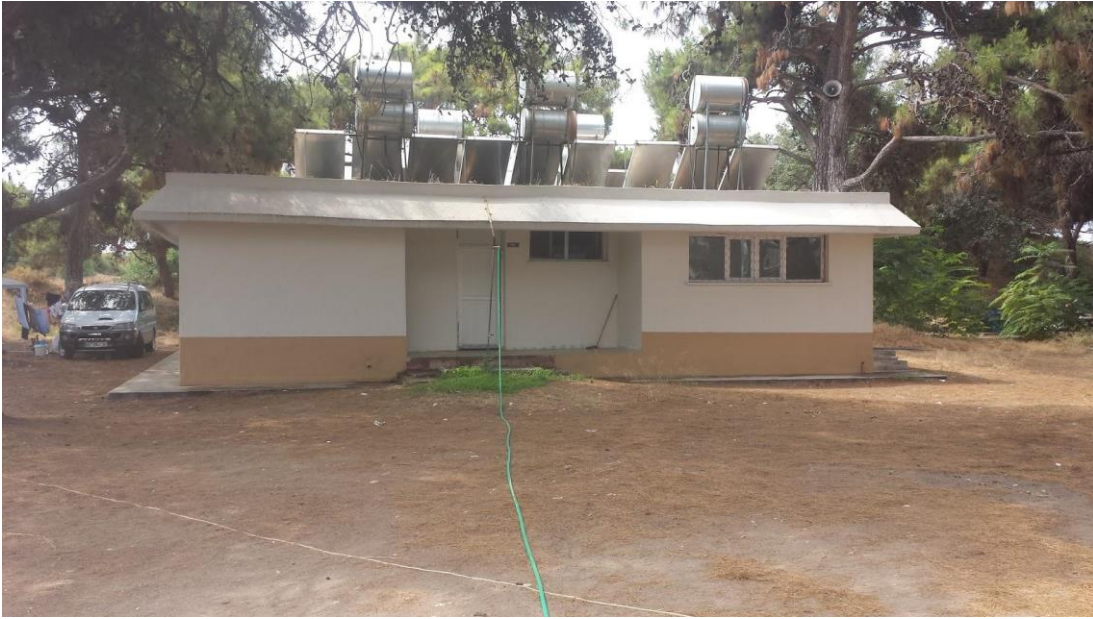
Resim 10. Kamp Alanı Sıhhi Tesis Binası
