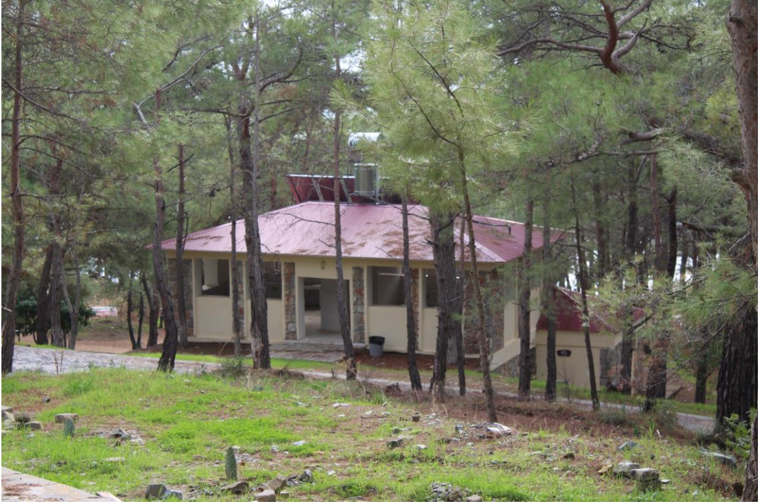
Resim 3. Karavan Kamp Alanı Servis Binası (wc, ortak mutfak, duř vb.)
