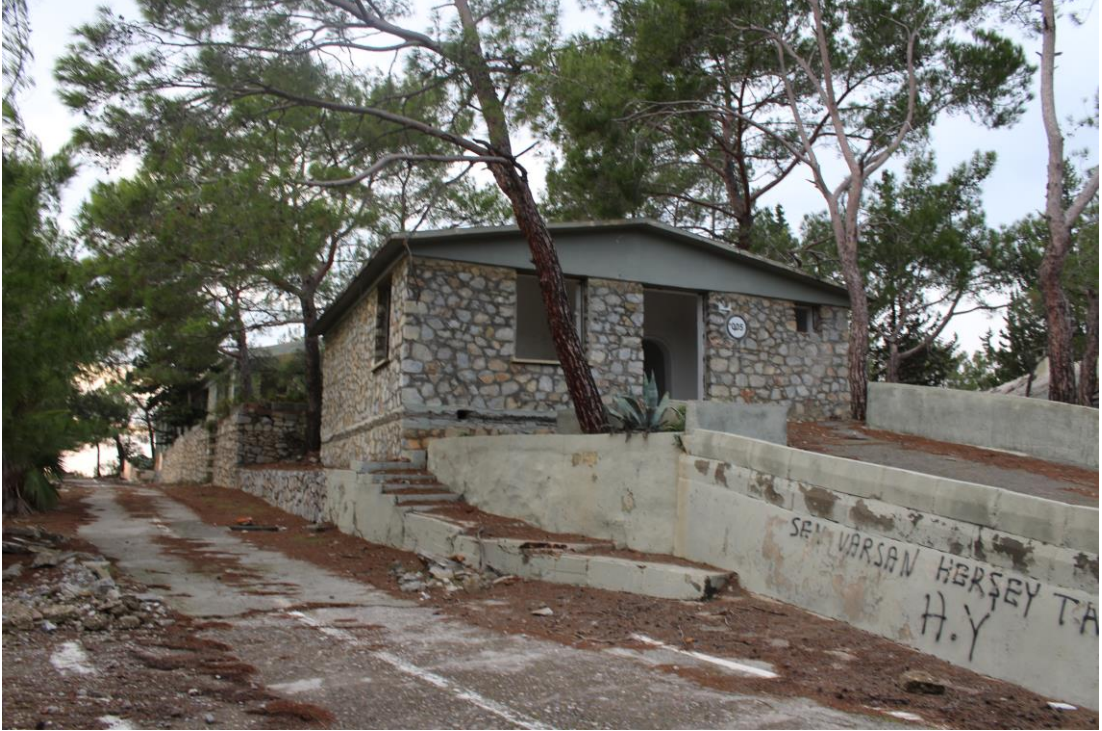
Resim 5. Yerleşke İçindeki Atıl Durumda Bulunan Yapılar
