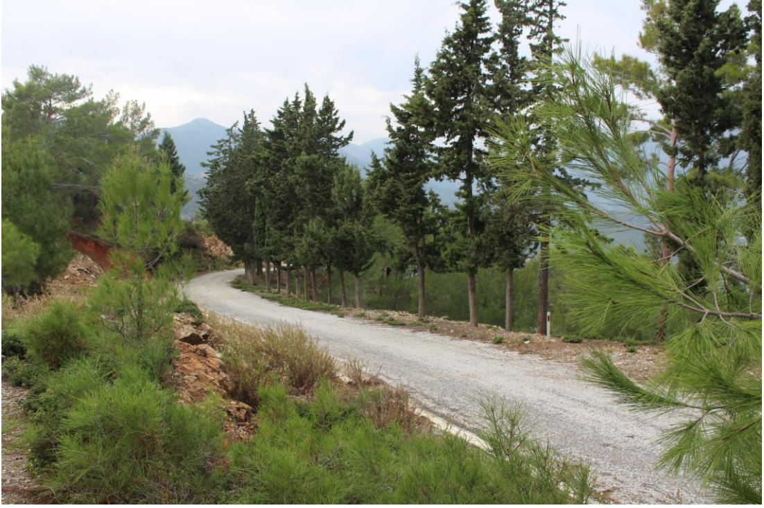
Resim 2. Yerleşkeye Giden Asfalt Yol
